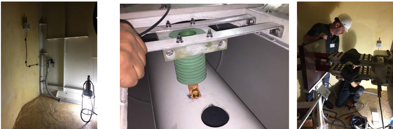
Figura 3. Montaje de electroductos, acoplador de barras y en recinto del generador.
